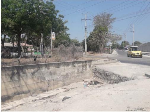
**Foto No. 3.** Canal de escorrentía de lluvias que descarga en el Lote 3A proveniente del barrio Ciudad Salitre
