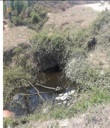
**Foto No. 6.** Canal de escorrentía de lluvias que descarga en el Lote 3A proveniente del Conjunto Residencial San Antonio de la constructora Amarillo donde se observa aguas negras y turbias
