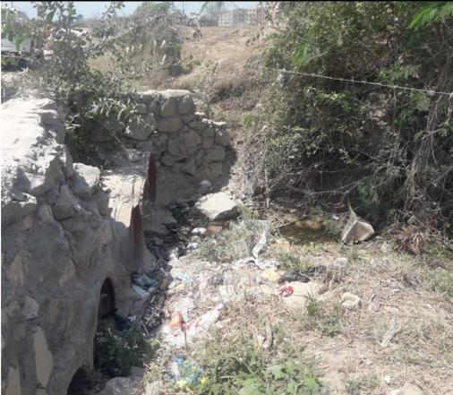
**Foto No. 5.** Canal de escorrentía de lluvias que descarga en el Lote 3A proveniente del Conjunto Residencial San Antonio de la constructora Amarillo donde se observa aguas negras y turbias
